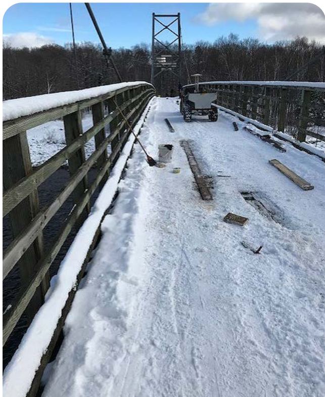
Réparation du pont Jean-Luc Sylvain sur la rivière Montmorency.
