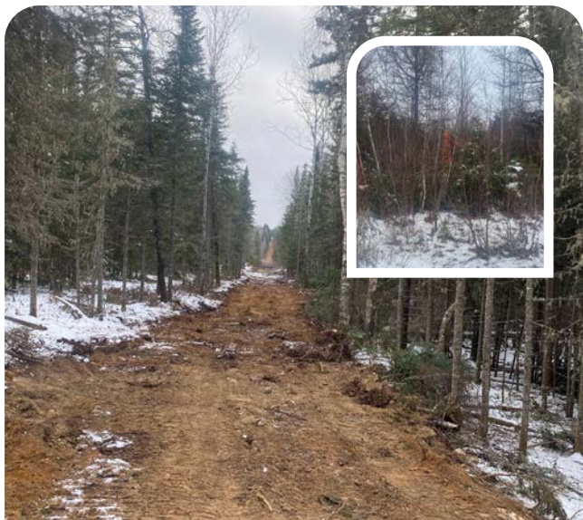
Travaux effectués dans le secteur Est.
